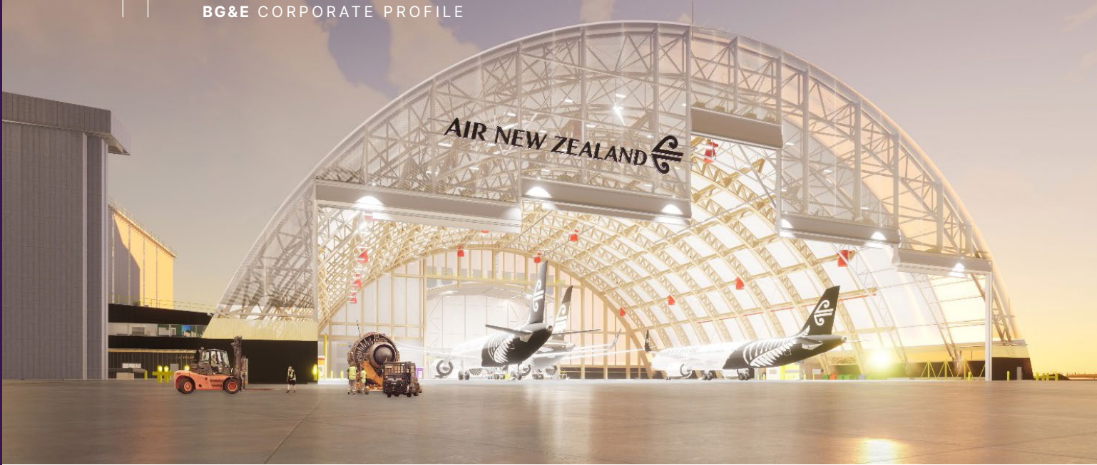
Air NZ Hangar 4 - Auckland, NZ.
